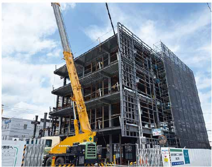
新たに建設中の新オフィスビル「ビエント第3ビル」
