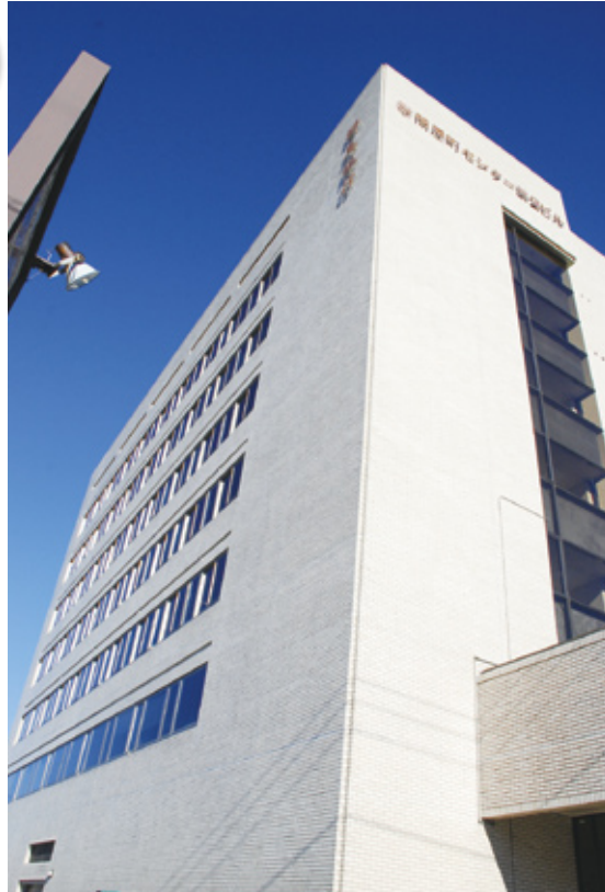
省エネ型ビルに生まれ変わった第2ビル
