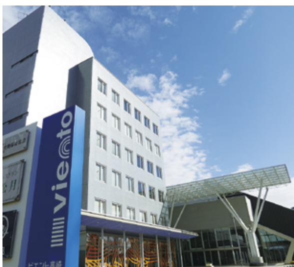
高崎市と災害時の施設利用協定を締結したビエント高崎本館
